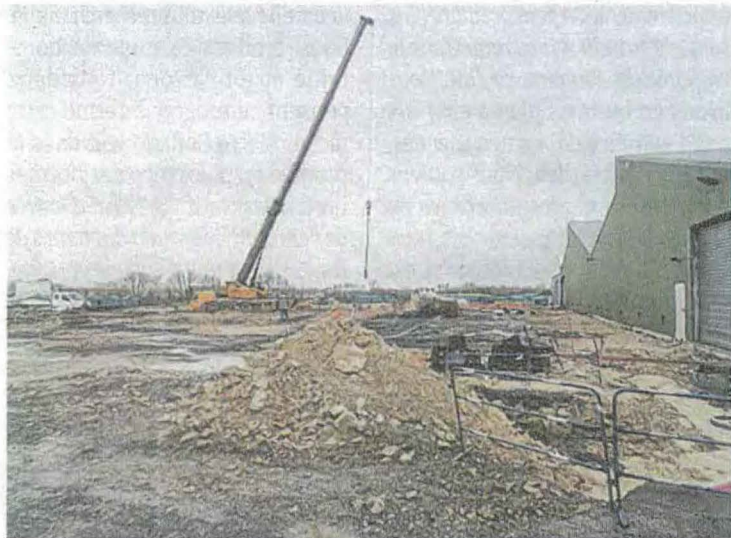
Les travaux de construction d'un bâtiment destiné à accueillir une nouvelle ligne de triage pour semences hybrides ont déjà débuté.
